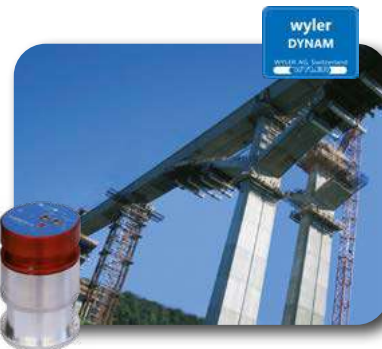
MONITORING OF BRIDGES ÜBERWACHUNG VON BRÜCKEN
